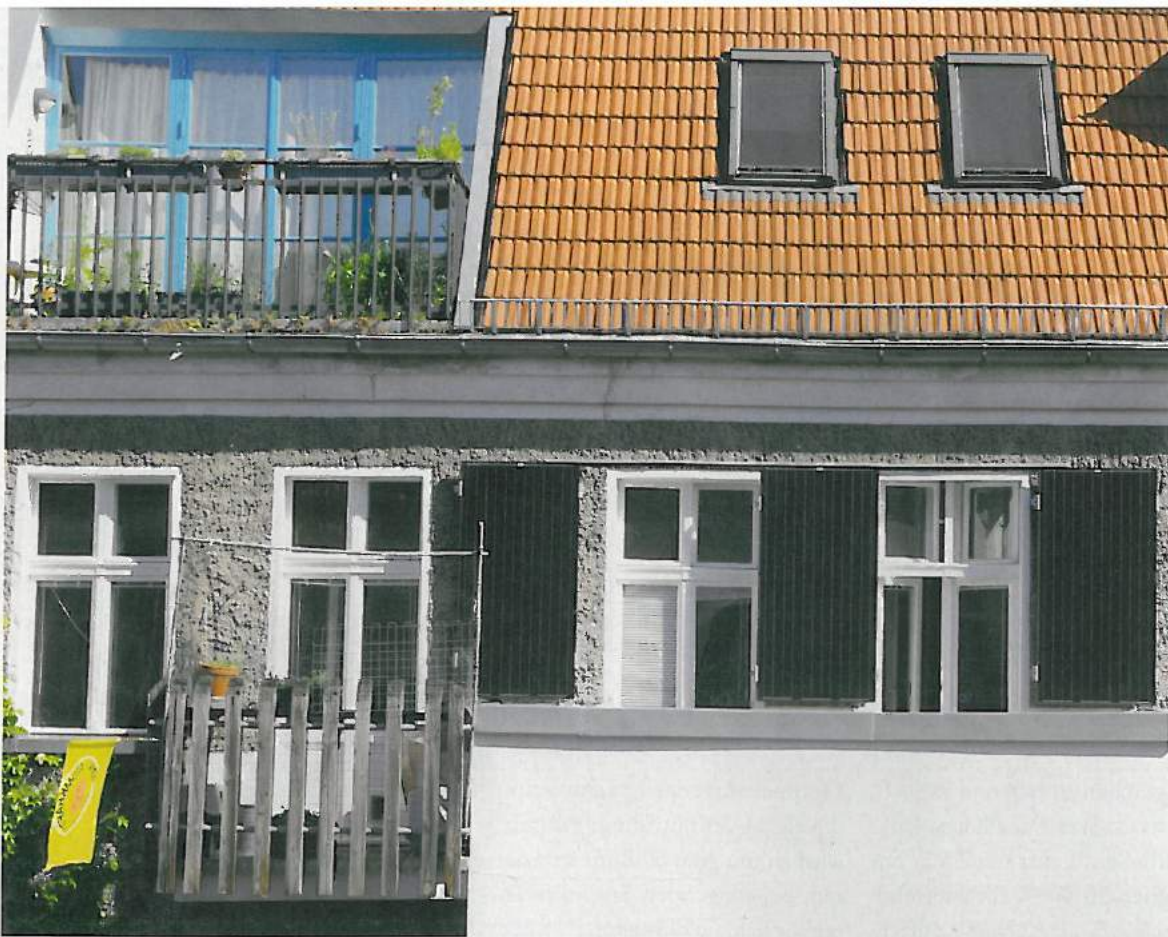
Gut getarnt: Module zur Direkteinspeisung aus dem Projekt „Solarrebell“.
