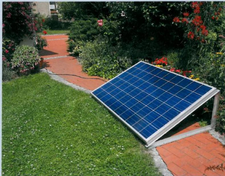
Ertragssteigerung: Dieses Steckmodul lässt sich ideal ausrichten, bei der Montage am Balkongeländer ist das aber nicht möglich
